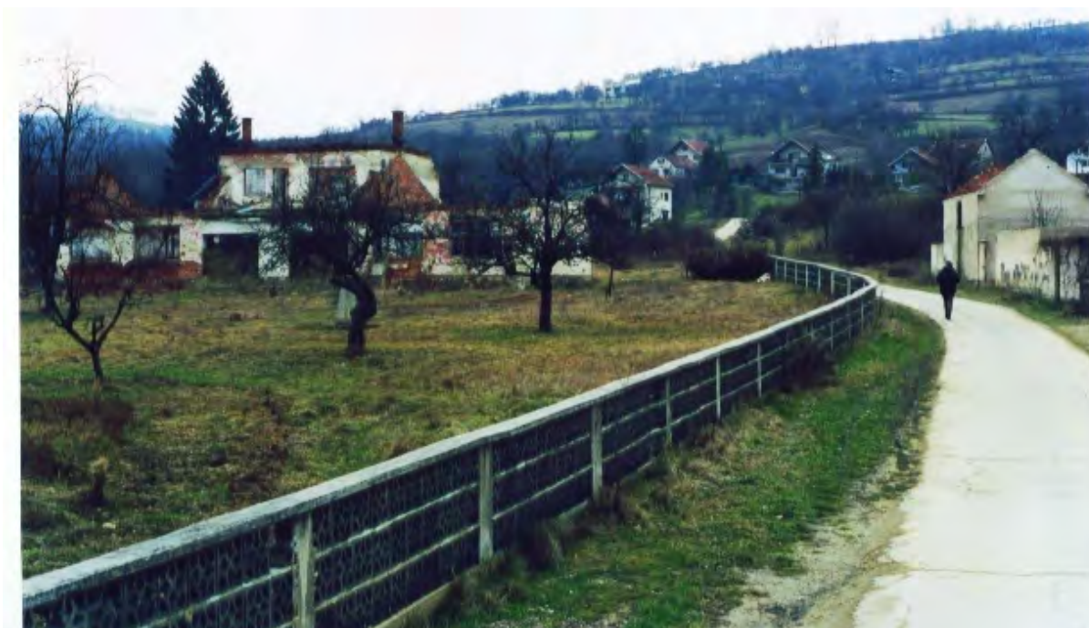
PORUŠENA OSNOVNA ŠKOLA U AHMIĆIMA
