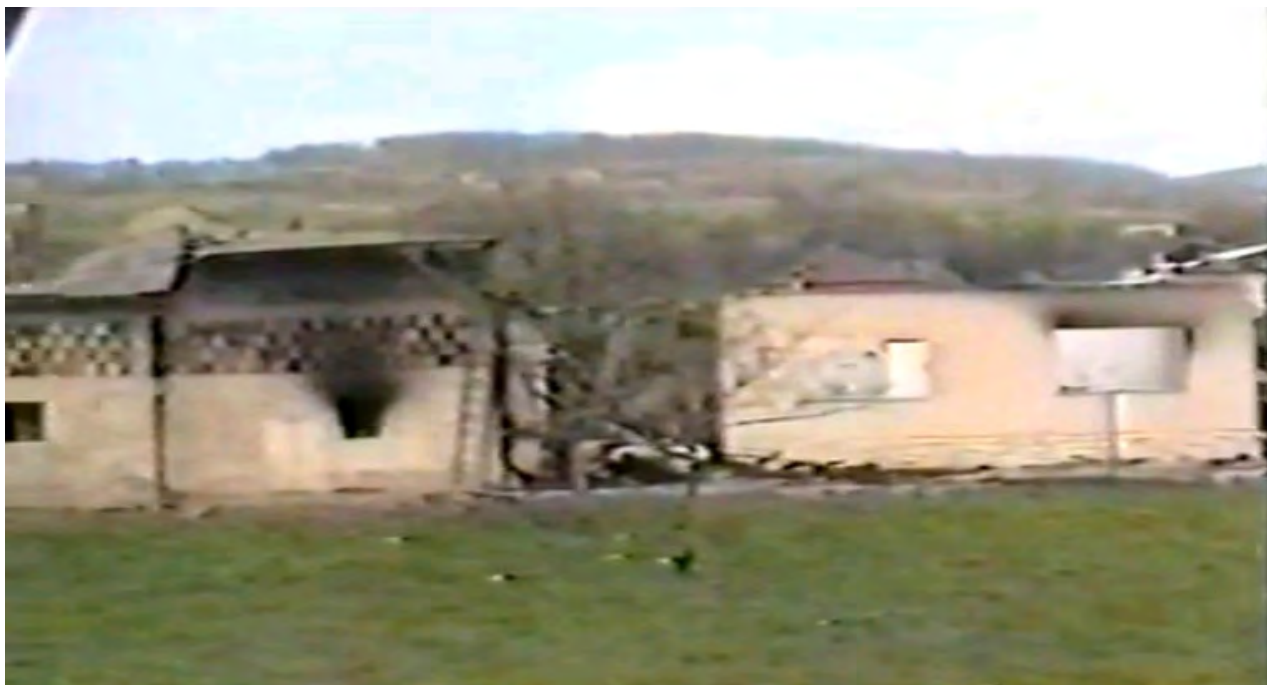
IZGORJELA KUĆA I ŠTALA OMERA PEZERA
