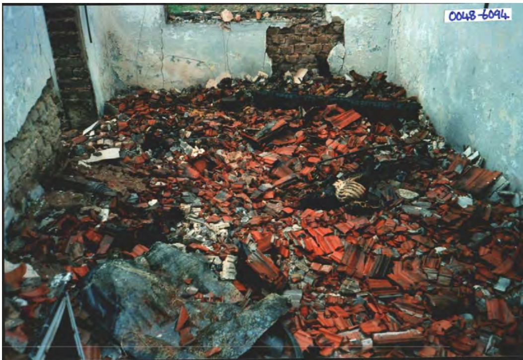
OSTACI IZGORJELIH TIJELA UBIJENIH BOŠNJAKA U KUĆI SAKIBA AHMIĆA
