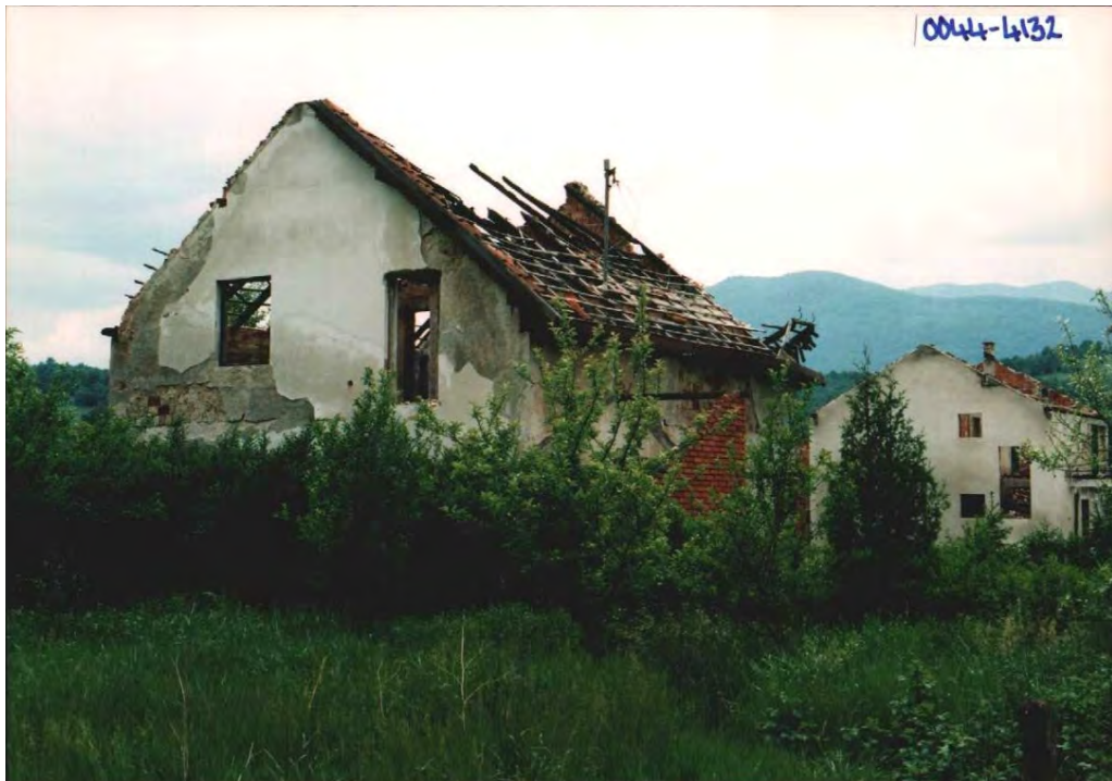
IZGORJELA KUĆA FEHIMA I SIDIKA AHMIĆA
