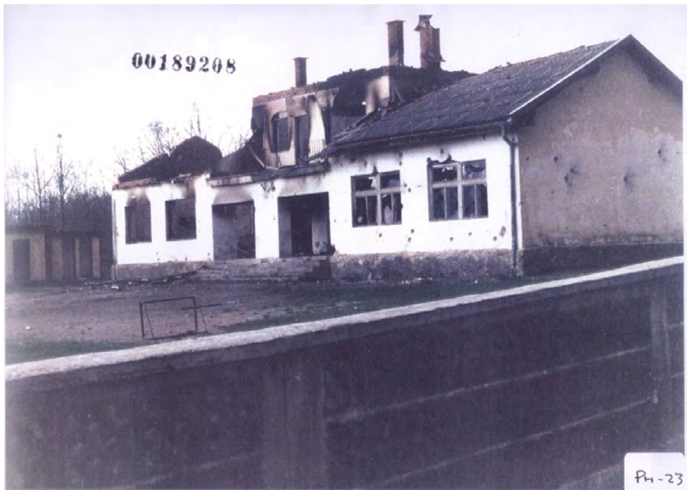
PORUŠENA OSNOVNA ŠKOLA U AHMIĆIMA
