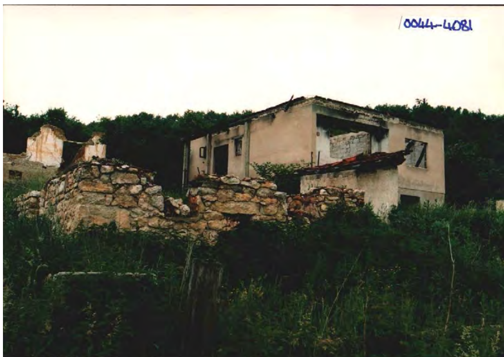
IZGORJELA KUĆA I ŠTALA ISMETA PEZERA
