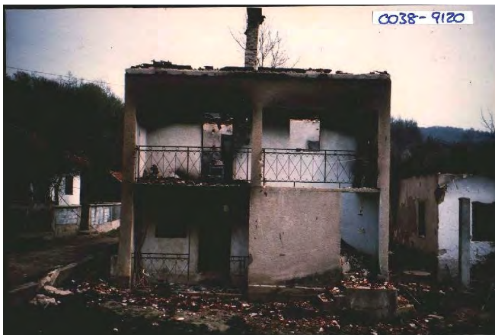
IZGORJELA KUĆA ZINETE PEZER
