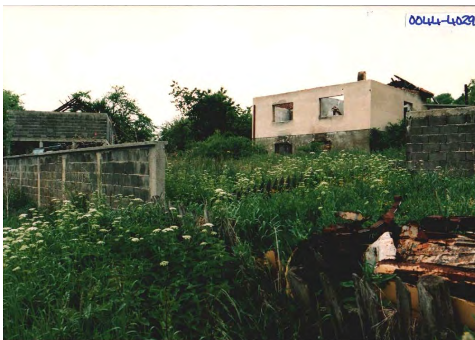
IZGORJELA KUĆA I ŠTALA ESADA AHMIĆA
