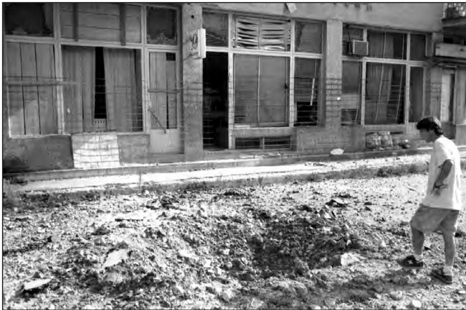
Granatiranje stambenih objekata
