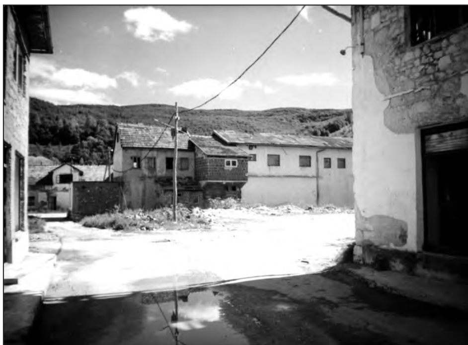
Mjesto porušene džamije u Kulen-Vakufu od koje ni temelji nisu ostali
