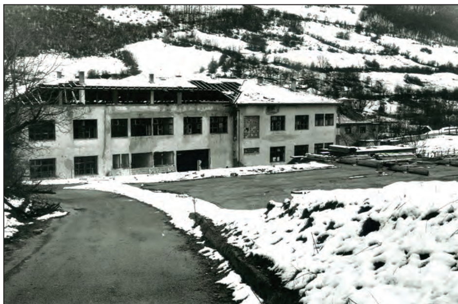
Oštećena i devastirana škola u Orašcu
