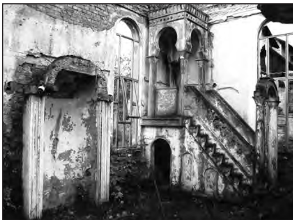
Unutrašnjost porušene džamije u Orašcu
