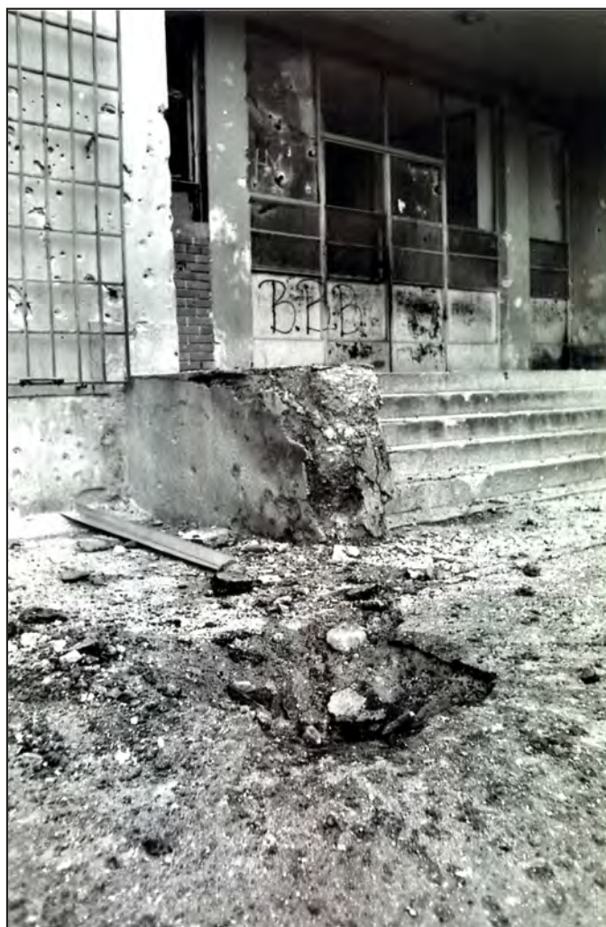
Granatiranje stambenih objekata
